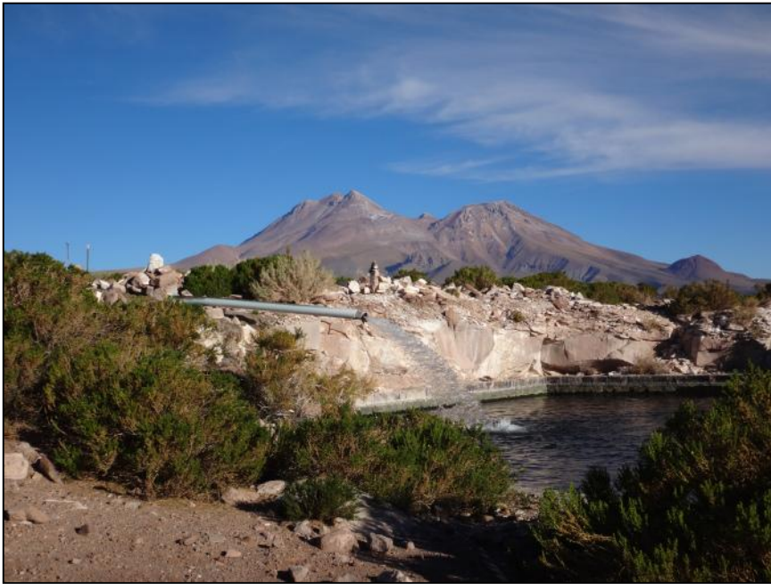
Figure 25 : La communauté de Talabre gère son propre système d'eau potable et possède une micro-turbine pour générer son énergie
